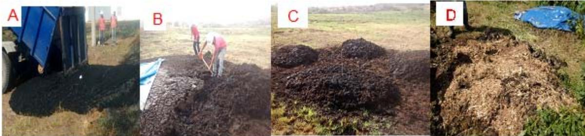
*Figura 4. A) Biosólido recién descartado del proceso de tratamiento de las aguas residuales municipales. B) Inicio del tratamiento pila estática de maduración con fácil manejo. C) Formaciones de pilas o montículos para iniciar caracterización física con muestreo aleatorio, D) obtención del abono orgánico como producto final.*
