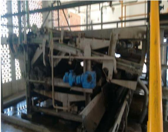
Figura 2. Filtración mecánica de lodos activados
